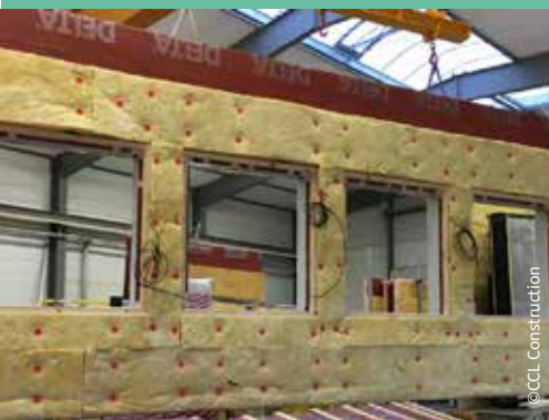
Une façade ossature bois isolante préfabriquée dans les ateliers de CCL Construction à Saint-M'Hervé.
