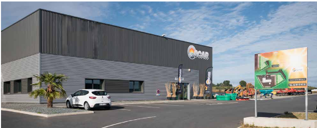
SCAR va s'implanter dans un bâtiment offrant une capacité de stockage intérieure de 12 000 m 2 . ©Atypix
