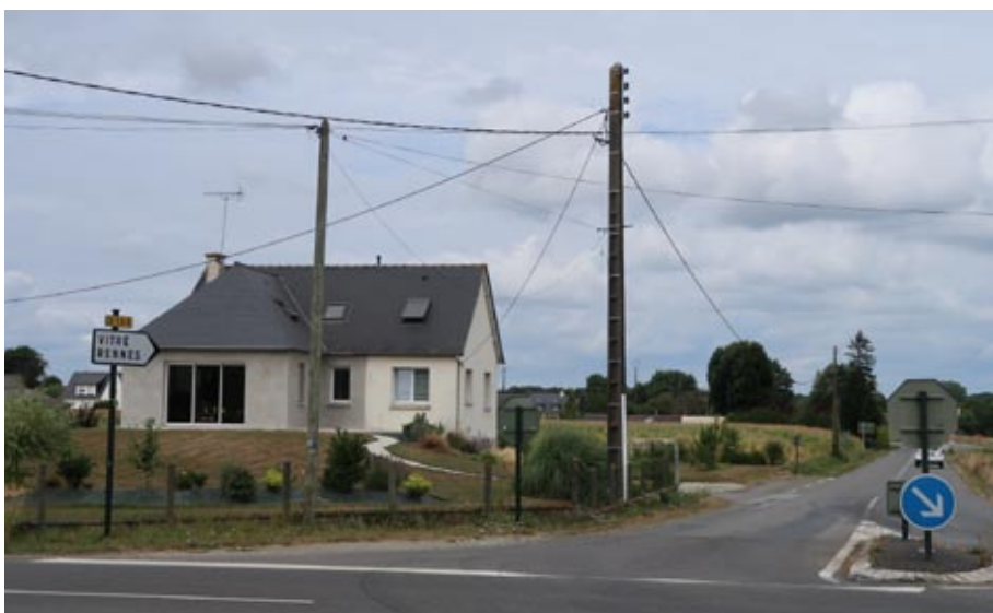
Construction dans un carrefour à Torcé.
