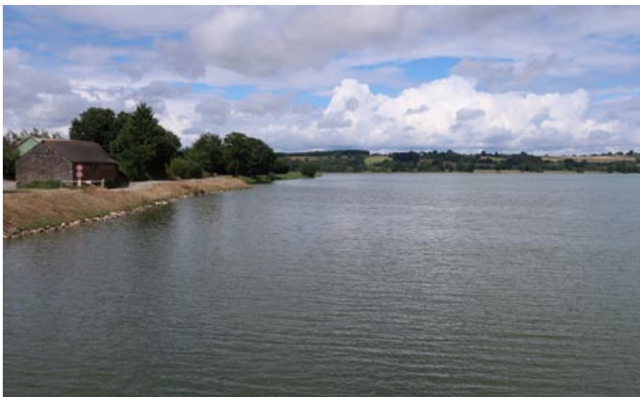
Le réservoir de la Cantache à Champeaux.
