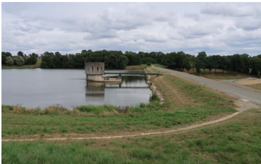
Barrage de la Valière. La rupture d'un tel ouvrage peut provoquer une onde de submersion dangereuse.
