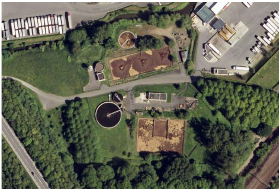
La station d'épuration de Vitré à Malipasse est de type «boues activées», elle rejette dans la Vilaine. Source : Géoportail.
