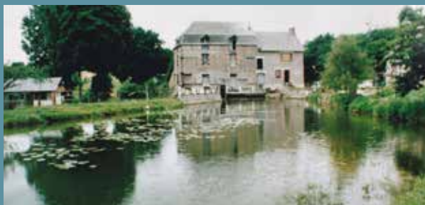
Vue d'ensemble du moulin de Ville-Cuite.
