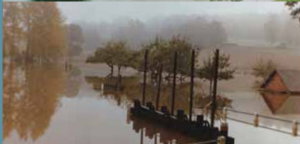
Inondation avant la fin des travaux à Ville-Cuite.
