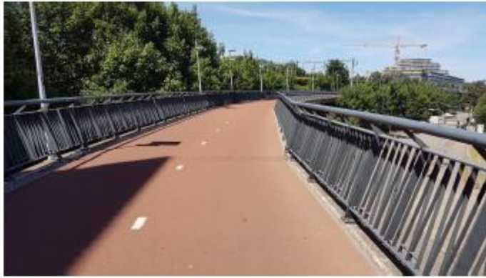
Figure 1 Nimègue, Pays bas: le garde-corps épouse la silhouette du cycliste et augmente ainsi la largeur roulable de la piste cyclable
