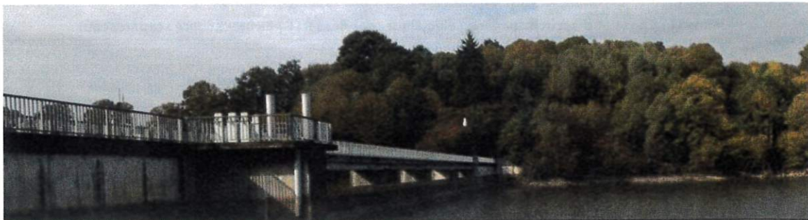
Barrage de la Cantache – ouvrage départemental construit en 1996
