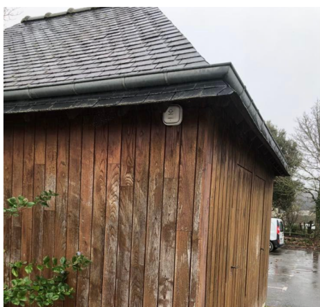
Figure 3 : Capteur Atmotrack installé en extérieur.
