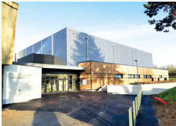
La halle Fayelle de Châteaubourg
