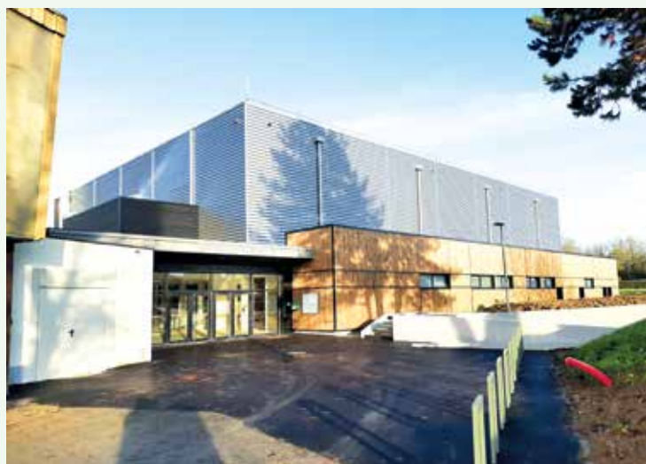
La halle Fayelle de Châteaubourg
